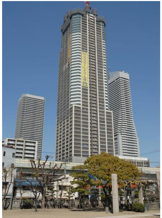
完成間近なクロスタワー大阪ベイ
