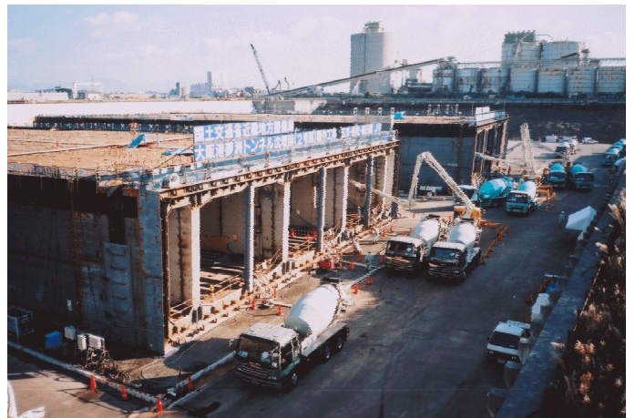
(11月29日 打設状況) 後方が堺臨海生コン工場
